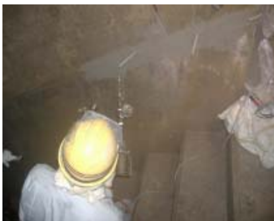
クラックシール 確認パイプ取り付け
