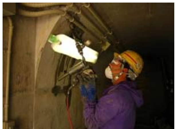
エア式注入機での注入作業
