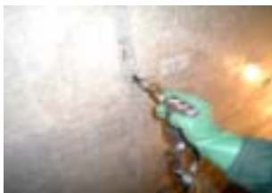
注入状況 (注入面リーク確認)
