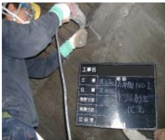
注入孔の削孔作業
