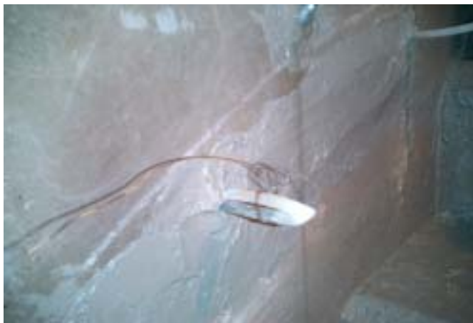
充填確認後パイプ結束
